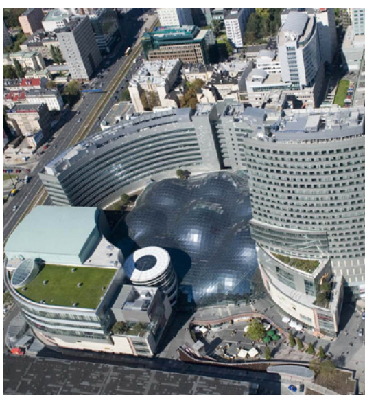
Charakterystyczny dach centrum handlowego „Złote Tarasy” wykonano ze stali i paneli szklanych.
