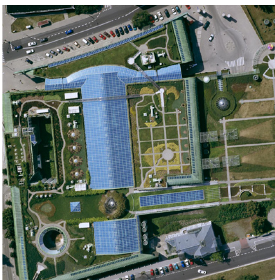
Zdjęcie lotnicze budynku Biblioteki Uniwersyteckiej w Warszawie.
