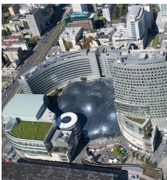
Charakterystyczny dach centrum handlowego „Złote Tarasy” wykonano ze stali i paneli szklanych.
